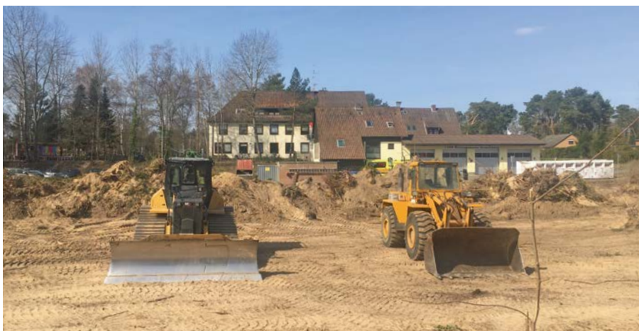
Die Arbeiten am neuen DRK-Zentrum haben begonnen
